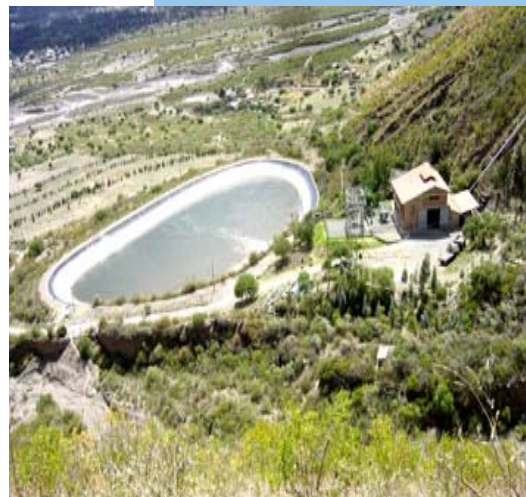
Reservorio en la cordillera. Fotografías: CAPEX.
