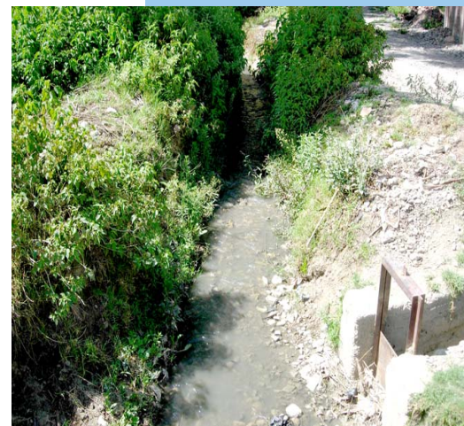
Canales de riego en Tiquipaya. Fotografías: CAPEX.
